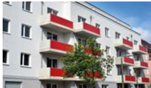
Wagner-Karree, Tannhäuserstraße 97-104: 147 Wohnungen
